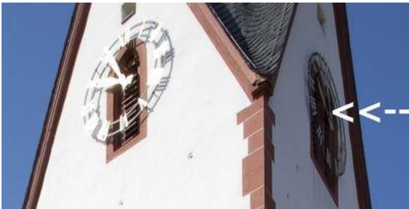
Diese Zeiger bleiben stehen! Turmuhr an der Nordseite defekt!
